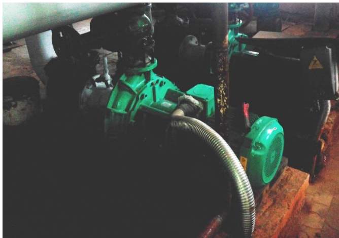
Рисунок 4. Насосное оборудование котельной №1
